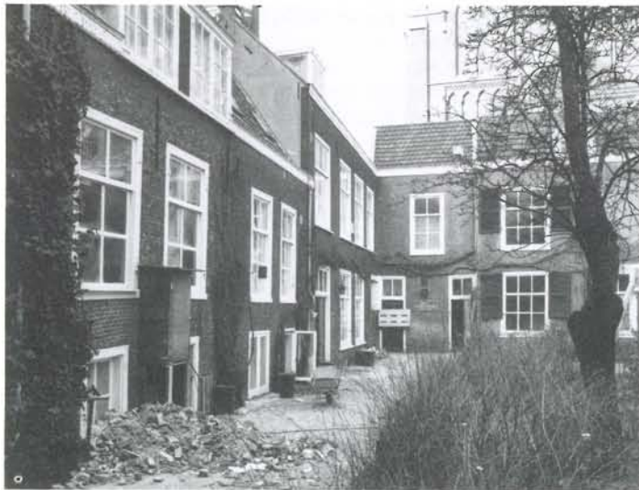
32. Blok D tijdens de uitvoering van de restauratie.
