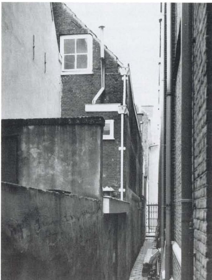
23. Gang tussen bouwblok C en de H. Jacobus de Meerdere, voor de restauratie.
