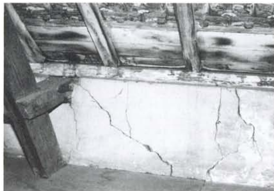
24. Bouwtechnische staat van kapvoet en borstwering (bouwblok A).
